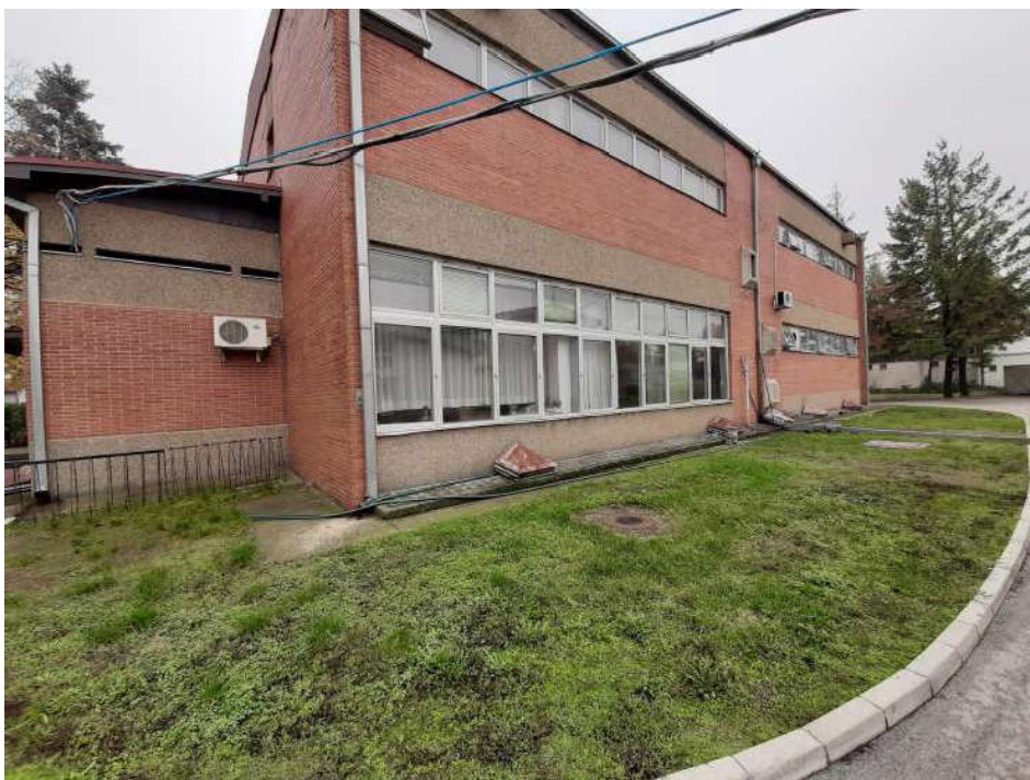
Сл.4 Фасадни прозорски панели-северозападна фасада
