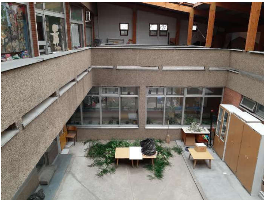
Сл.2 Прозорски панели светларника у приземљу
