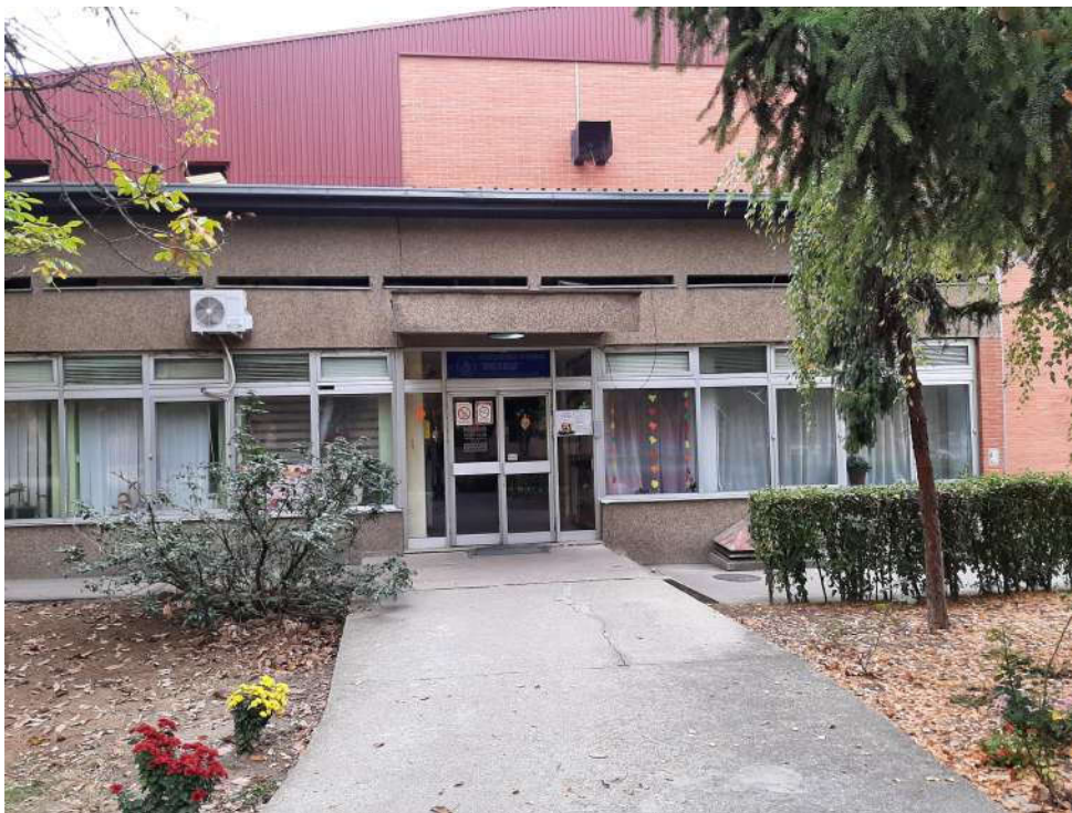
Сл.6 Фасадни прозорски панели-североисточна фасада
