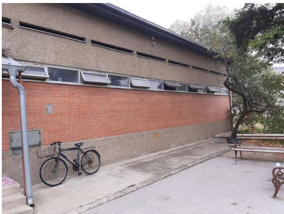
Сл.5 Фасадни прозорски панели-југозападна фасада
